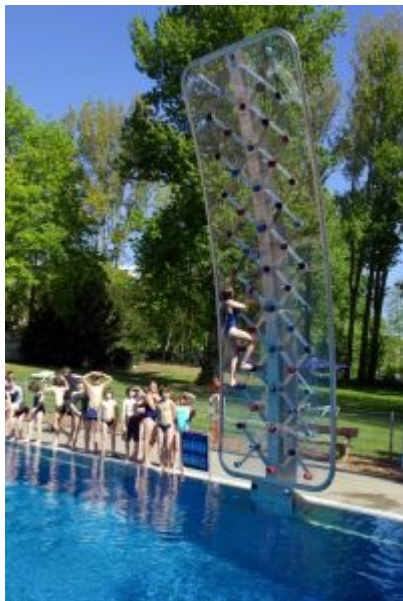
Bild 2: Die Kletteranlage am Beckenrand ist ein wahrer Publikumsmagnet. (Quelle: Stahl-Informations-Zentrum / born product ideas)
