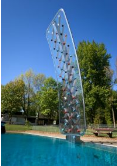
Bild 3: An der Fachwerkkonstruktion aus Edelstahl Rostfrei sind rutschfeste Klettergriffe für verschiedene Routen mit unterschiedlichen Schwierigkeitsgraden montiert.
